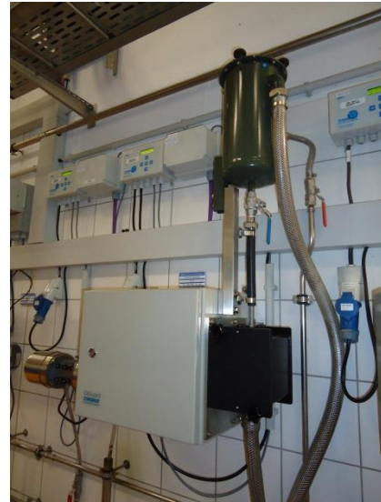
Bild 2: Installationsbeispiel eines Oil-in-Water Analyzers OilGuard
