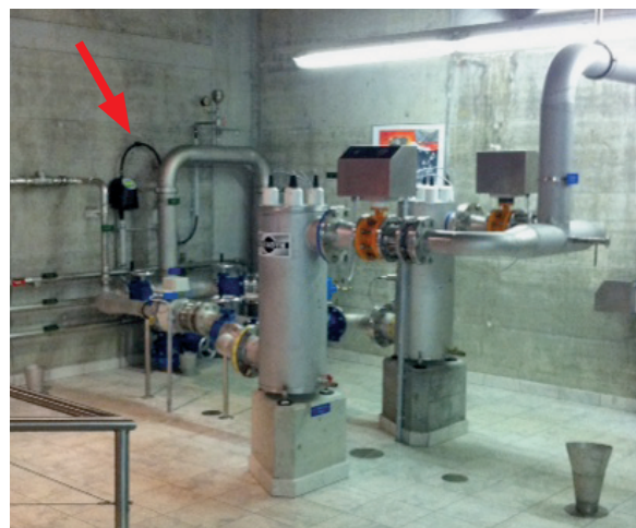
UV-Reaktoren mit AquaScat WTM vor/nach der Desinfektion
