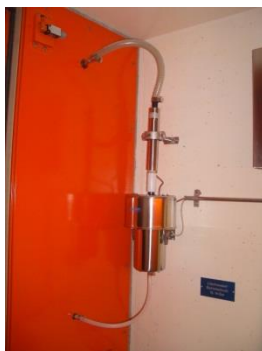
Bild: VisGuard Mini-extraktiv in einer SOS-Nische installiert
