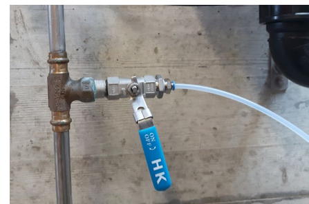
Bild 5: Einfache Durchflusseinstellung zum Erreichen des nötigen, dauerhaften Durchflusses von 200 bis 400 ml/min beim Anschluss der Online-Probeentnahme
