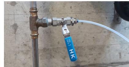
Bild 5: Einfache Durchflusseinstellung zum Erreichen des nötigen, dauerhaften Durchflusses von 200 bis 400 ml/min beim Anschluss der Online-Probeentnahme
