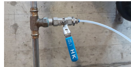
Figure 5: Réglage de débit simple pour obtenir les 200 à 400 ml/min en permanence, nécessaire lors du prélèvement en ligne
