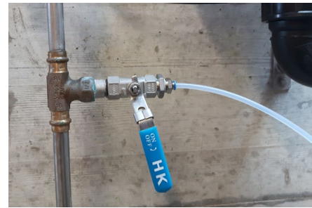
Figure 5: Réglage de débit simple pour obtenir les 200 à 400 ml/min en permanence, nécessaire lors du prélèvement en ligne
