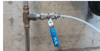
Figure 5: Réglage de débit simple pour obtenir les 200 à 400 ml/min en permanence, nécessaire lors de la mesure en continu avec le BactoSense
