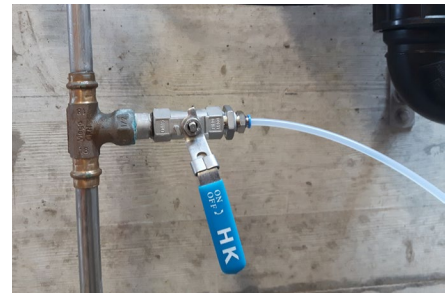
Figure 5: Réglage de débit simple pour obtenir les 200 à 400 ml/min en permanence, nécessaire lors de la mesure en continu avec le BactoSense
